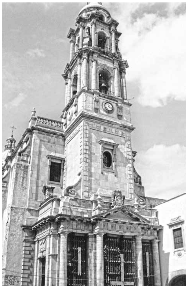
Fotografía del sistema de apuntalamiento dalmine en el pórtico de la iglesia de El Carmen, Celaya, Gto. Marzo de 2006. Fotografía: Isabel Cervantes Tovar (ict)
