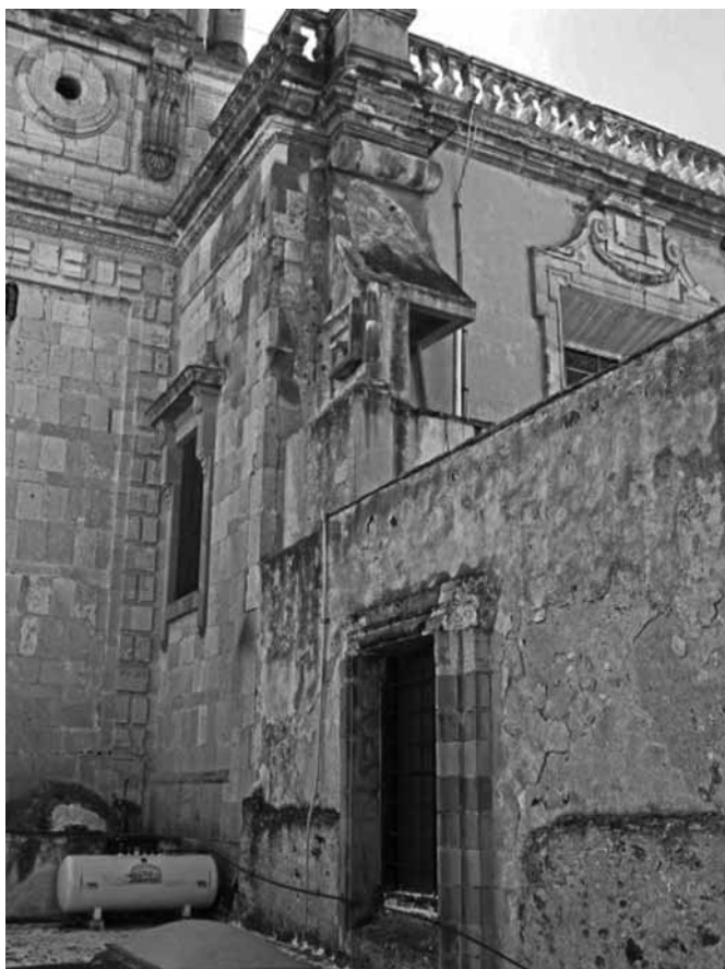
Vista de la eliminación parcial del contrafuerte noreste, inmediato a la torre (vista Este-Oeste), iglesia de El Carmen, Celaya, Gto. Marzo de 2006. Fotografía: ICT
