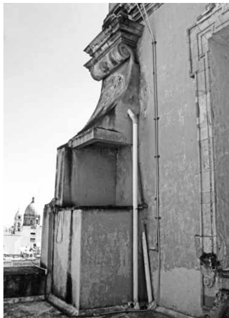
Vista de la eliminación parcial del contrafuerte noreste, inmediato a la torre (vista Oeste-Este), iglesia de El Carmen, Celaya, Gto. Marzo de 2006. Fotografía: ICT
