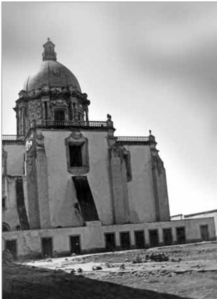
Fotografía de los solares que pertenecieron al antiguo convento de El Carmen, Celaya, Gto. s/f , Archivo Histórico de Monumentos Coloniales, INAH
