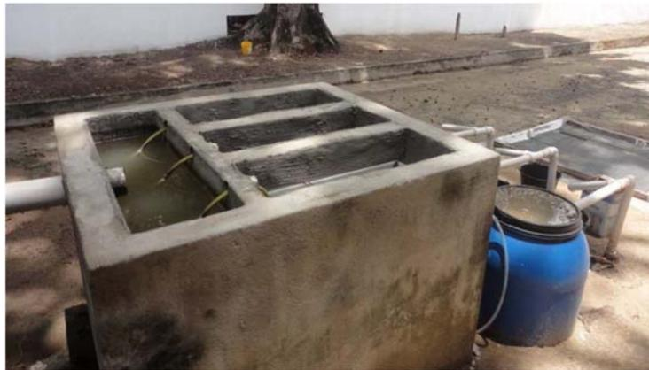
**Figura 4.** Caixa de distribuição de vazão (SOUZA, 2014).
