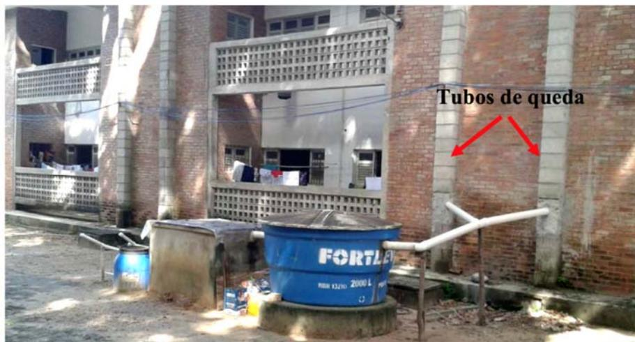
**Figura 1.** Esgoto afluente ao sistema de tratamento - tubos de queda. (SOUZA, 2014).
