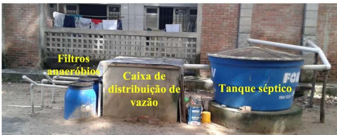
Figura 3. Visão geral do sistema (sem os filtros de areia) (SOUZA, 2014).
