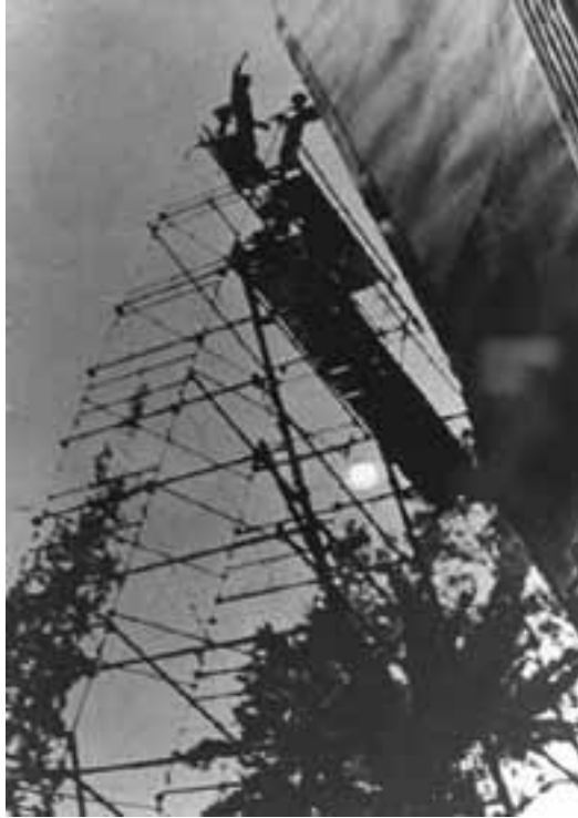
Fotografía tomada durante la realización de la pintura. Nótese como se ha ondulado ya la fibra de vidrio en el panel triangular lateral debido al trabajo de dilatación y contracción del material por los cambios de temperatura.
