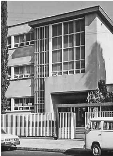
Colegio María Luisa Olanier, en San Luis Potosí Cossío y Algara Arquitectos Fotografía: Jesús Villar Rubio (JVR)
