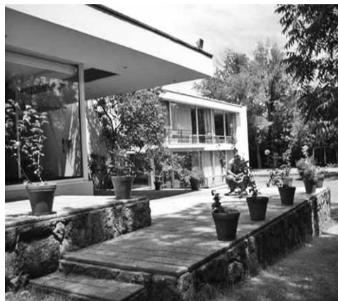
Casa Zendejas Hernández Cossío y Algara Arquitectos, 1966 Fotografía: JVR
