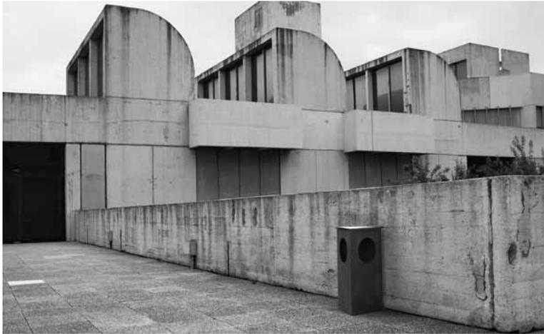
Deterioros existentes en lucernarios, muretes y paramentos de la Fundació. En los muretes de la terraza también se aprecian los desprendimientos de material, las grietas y las varillas oxidadas. Foto: MEC, julio de 2002
