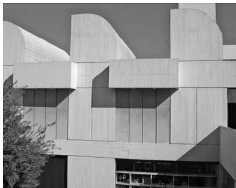
Vista de los lucernarios y paramentos de concreto armado *-in situ* y prefabricados- después de haber sido intervenidos. Como acabado final, se limpió totalmente la superficie de concreto y se aplicó una pintura que impidiera el paso de agua, pero permitiera la salida de vapor de agua. Foto: MEC, febrero de 2008.
