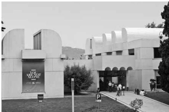
Vista del acceso de la Fundació Miró, Barcelona, España (1972-75). Se aprecia el diverso juego de volúmenes en la terraza, en especial, las bóvedas de cuarto de círculo de concreto armado. Además se observa el contraste de texturas entre el concreto *in situ* pulido y los paneles prefabricados con acabado rugoso de los muros. Foto: MEC, junio de 2011.
