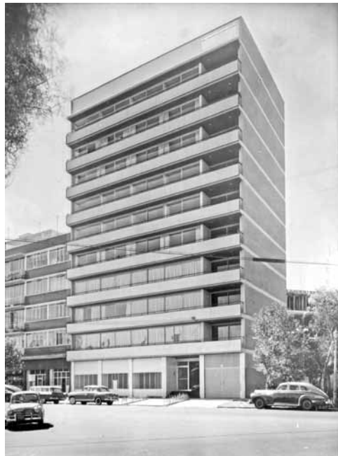
Fotografía del edificio de departamentos en la calle de Newton núm. 156, circa 1959, archivo Albin.
