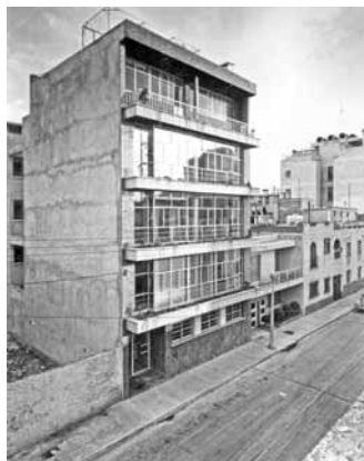
Fotografía del edificio de departamentos en la calle de Puerto Real núm. 38, circa 1950. Archivo Albin.
