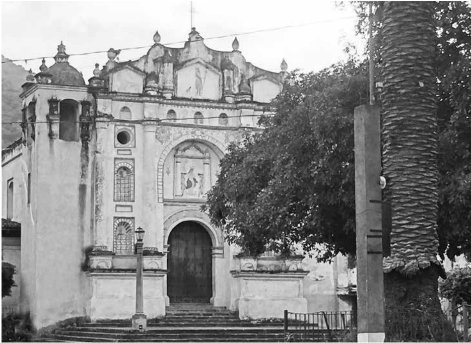
Iglesia de San Juan del Obispo, en Antigua Guatemala. Fotografía: Elaboración: SP, noviembre de 2014
