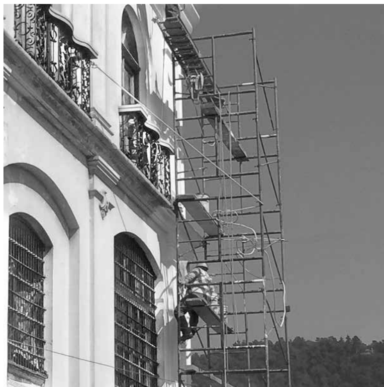
Remozamiento de edificio histórico en la ciudad de Quetzaltenango. Fotografía: SP, febrero de 2015
