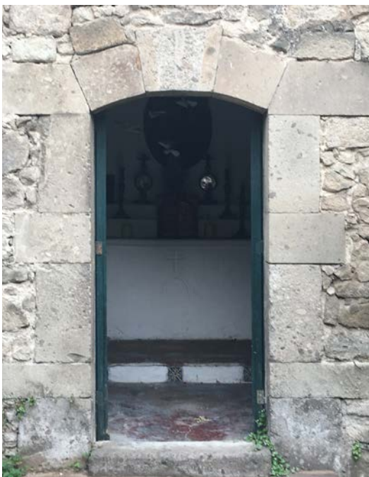
Arco escarzano en el rancho San Juan Totoltepec. Fuente: Fotografía del autor, 2017
