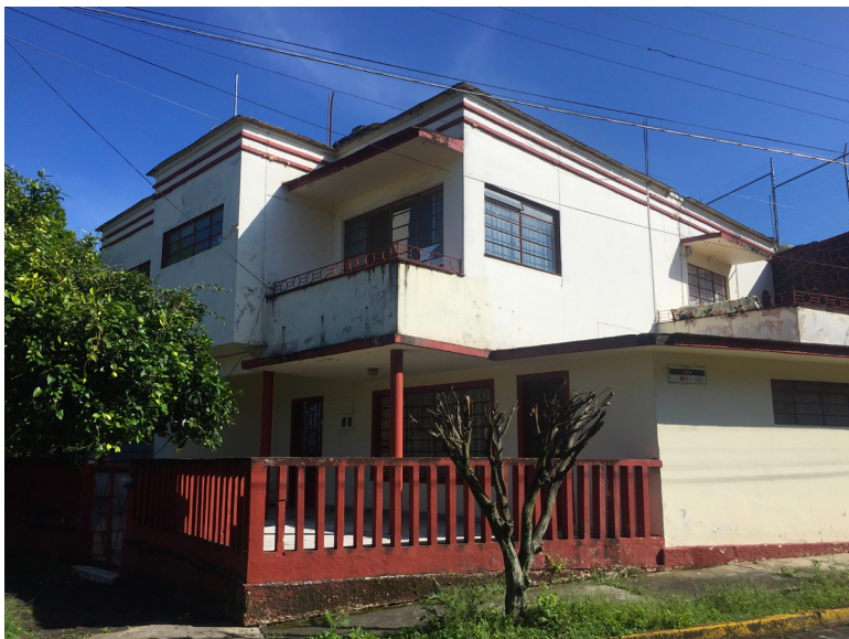
Casa posiblemente cercana a la línea racionalista enunciada por el Ing. Téllez Muñoz, con algunos detalles de molduras de remate en Tuxtla y Paseo de Las Palmas núm. 2, con volúmenes y bardas bajas construidas probablemente con elementos colados de concreto. Fotografía: Fernando N. Winfield Reyes, 24 de julio de 2020.
