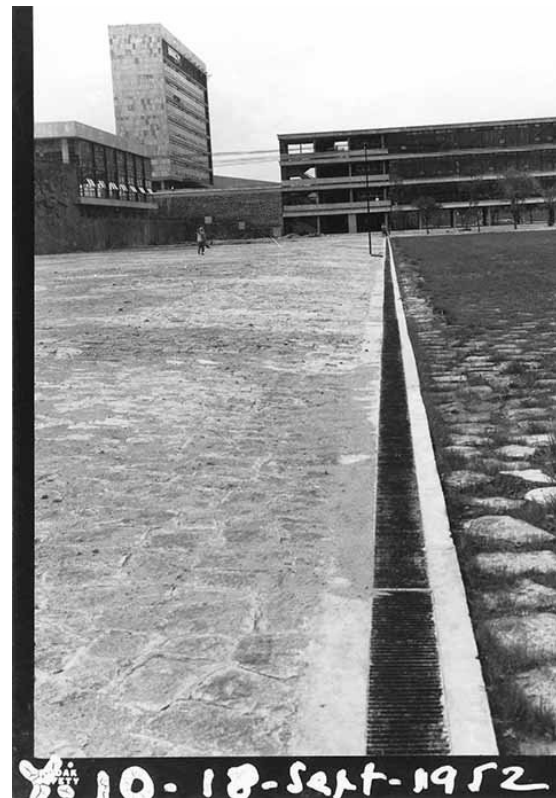
Pavimento de la plataforma poniente (izquierda) a base de roca volcánica colocada a hueso y pavimento de la explanada de Las Islas (derecha) construido con bloques de roca y juntas de tierra vegetal, 18 de septiembre de 1952. ISSUE/AHUNAM/Colección UNIVERSIDAD/Construcción de CU/cu-003702.
