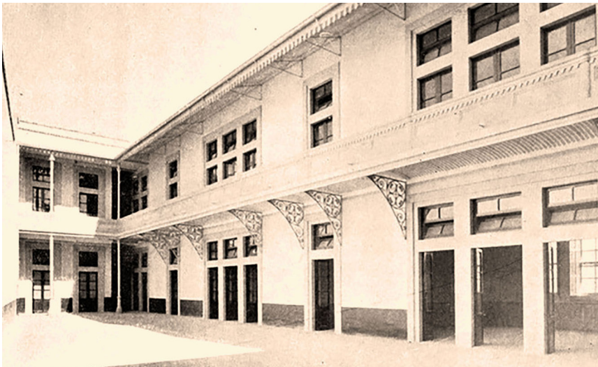
Figura 3. En la imagen de la Escuela No. 2 puede observarse la posición y el tamaño de los vanos, así como la ventilación cruzada que se logra en las aulas. El Arte y la Ciencia , vol. VII, núm. 9, 1906.
