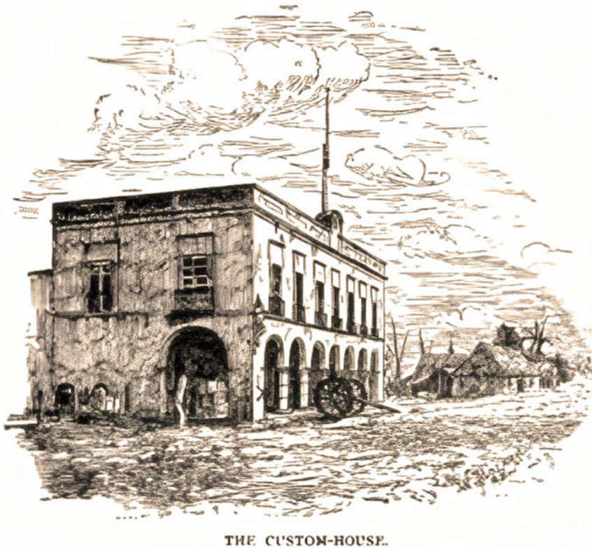
Figura 3. Litografía del edificio de la aduana marítima, 1871.
