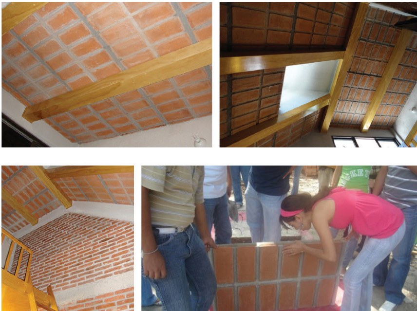
Figura 6. Techo prefabricado Termolosa con acabado aparente integrado (petatillo), desarrollo tecnológico de Gabriel Castañeda Nolasco, 2010. Fuente: Gabriel Castañeda Nolasco.
