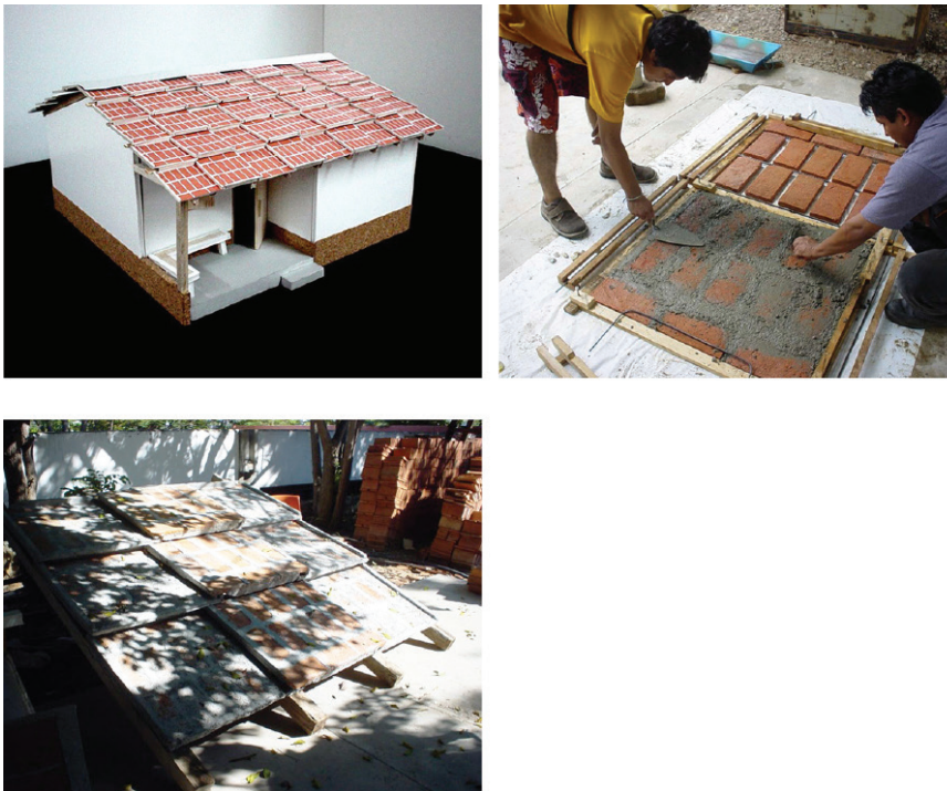
Figura 10. Techo prefabricado Tejuelón, desarrollo tecnológico de Gabriel Castañeda Nolasco, 2003.
