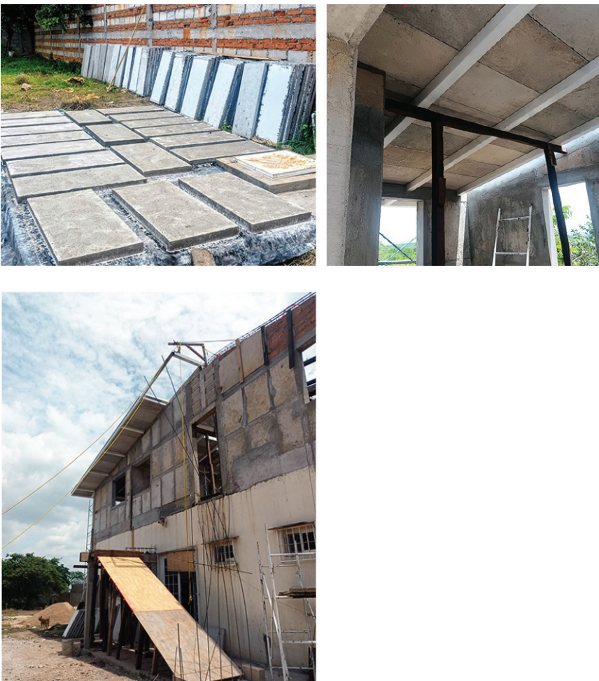
Figura 7. Techo prefabricado Termolosa, desarrollo tecnológico de Gabriel Castañeda Nolasco, 2024. Fuente: Gabriel Castañeda Nolasco.
