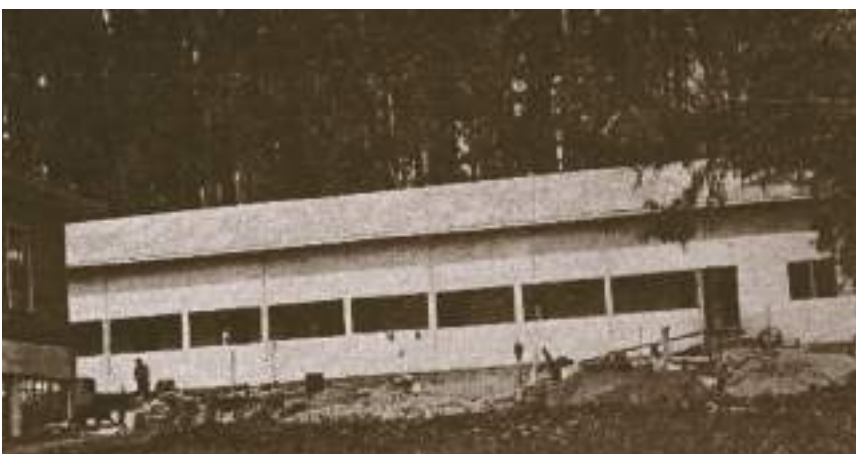
Figura 4b. Nuevo pabellón de aislamiento.
