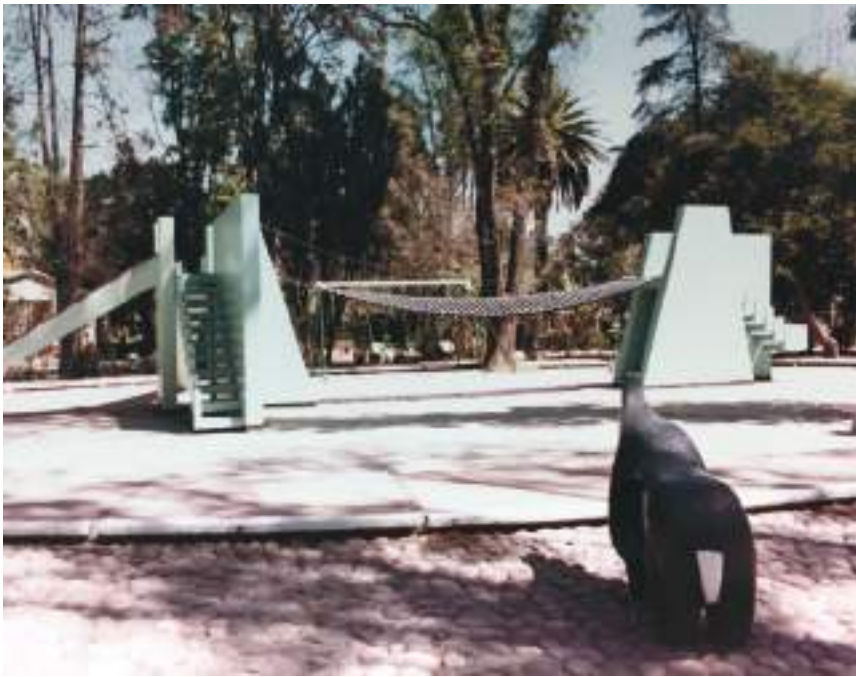
Figura. 8. Edmundo Rodríguez, pabellón de juegos con puente colgante, en primer plano los animales de concreto de Alberto Pérez Soria, parque de los Venados, 1971-1976.
