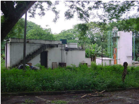
Figura 1: Vista do sistema de pré-tratamento (tratamento preliminar e tratamento anaeróbio)
