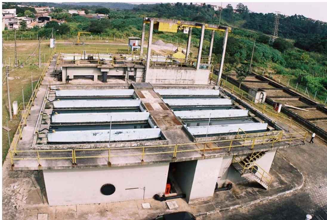
Figura 1 – Vista Geral da ETE Ribeirão Pires
