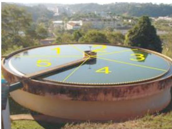
**Figura 5: Vista do decantador, com a representação das cinco regiões de medição de vazão**
