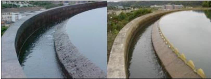
**Figura 1-Instalação de bordas vertedouras ajustáveis no decantador**
