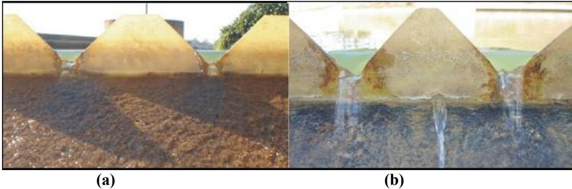
**Figura 8: Detalhes da coleta de água decantada nas bordas vertedouras do decantador, regiões 4 (a) e 2 (b).**
