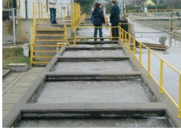
**Imagen N° 1: Floculador mecánico existente, y vista de canal de agua coagulada durante la prueba hidráulica ( $Q = 12.000 \text{ m}^3/\text{h}$ )**
