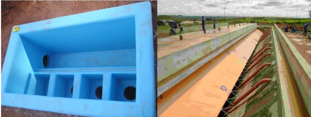
**Figuras 7 e 8** – Implantação de alterações de projeto nos reatores UASB das ETEs Paranoá (revestimento das caixas de coleta do efluente tratado com fibra de vidro) e São Sebastião (substituição do material dos separadores de fases por laminado vinílico).
