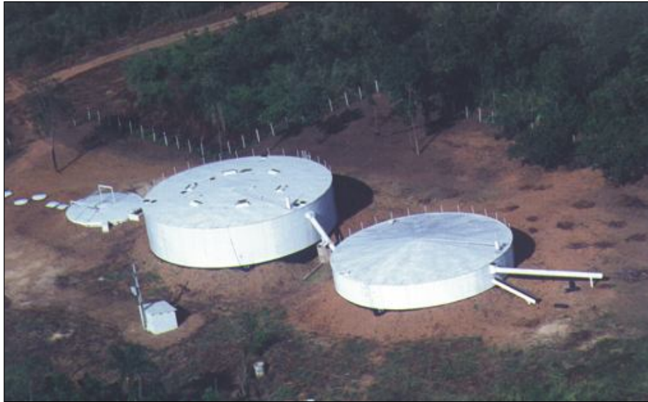
Figura 2. Vista aérea da ETE Brejo Comprido
