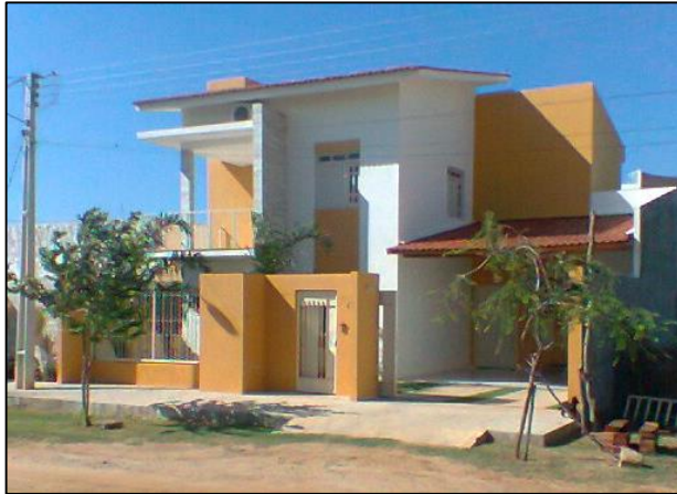
Figura 1. Unidade Residencial. Cidade de Caicó-RN-Brasil
