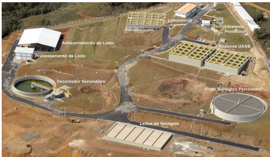
Figura 2. Fotografia aérea da ETE Vassoural em obras. Fonte: Arquivo fotográfico Sanepar (2010)
