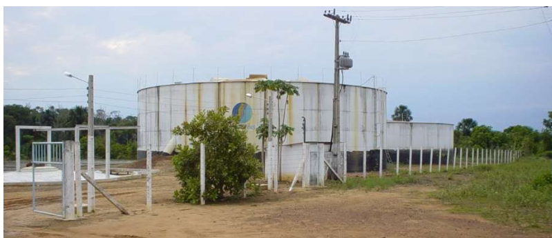
Figura 4. Tratamiento secundário (reator UASB)
