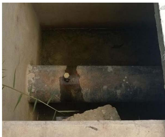
Figura 4. Entrada da Subadutora no R.A.
