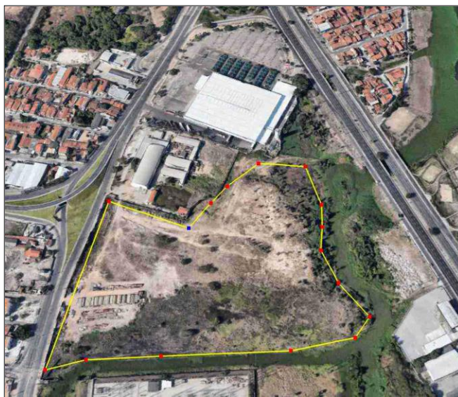
Figura 2. Localização do reservatório. Fonte: Google Earth Pro (imagem de 26 agosto 2013)
