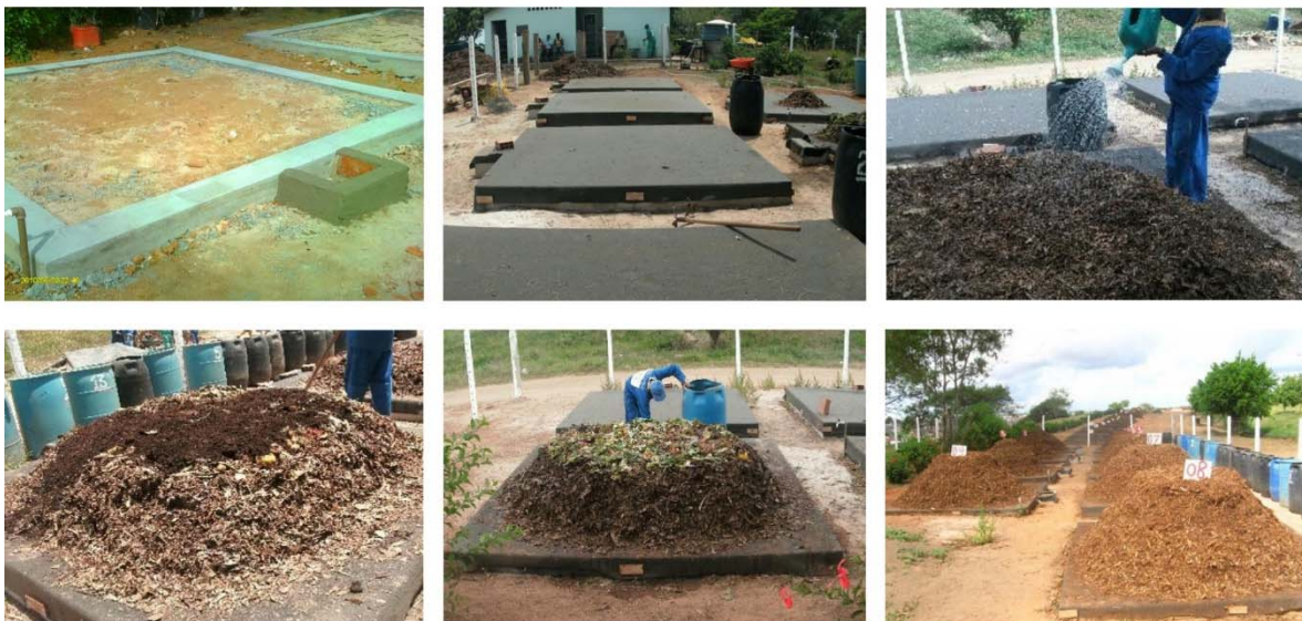
Figura 1. Detalhe de construção das bases com impermeabilização e montagem das pilhas.
