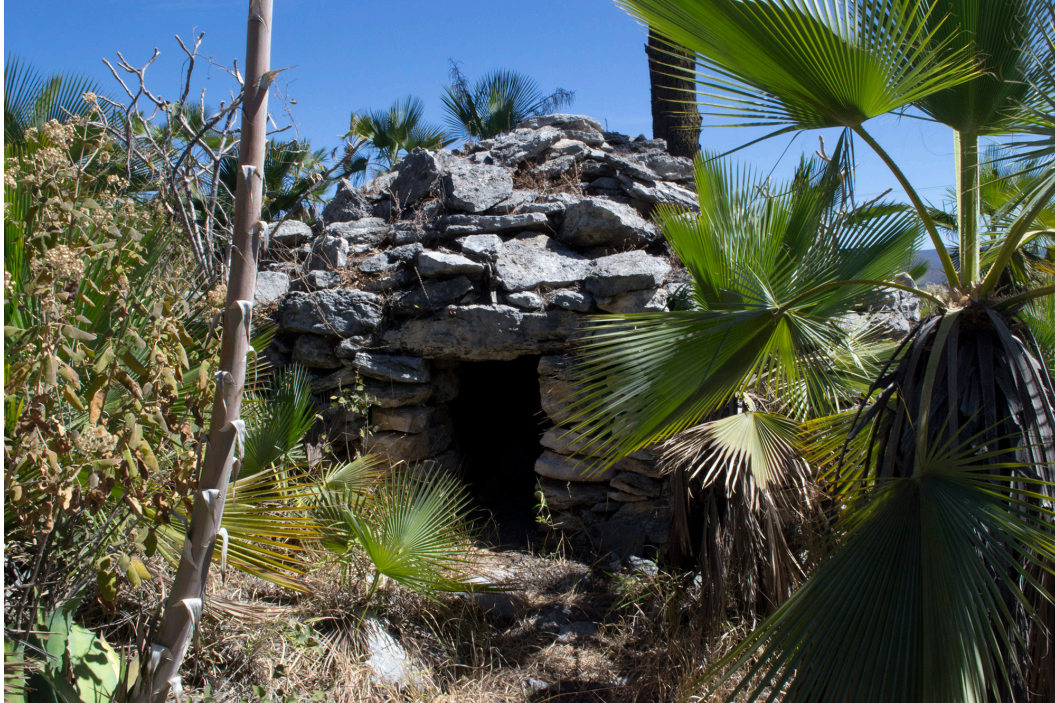
Figura 13. Construcción de techo abovedado en Guadalupe Llano de Avispas, Tilantongo (fotografía de Betsabé Piña Morales).
