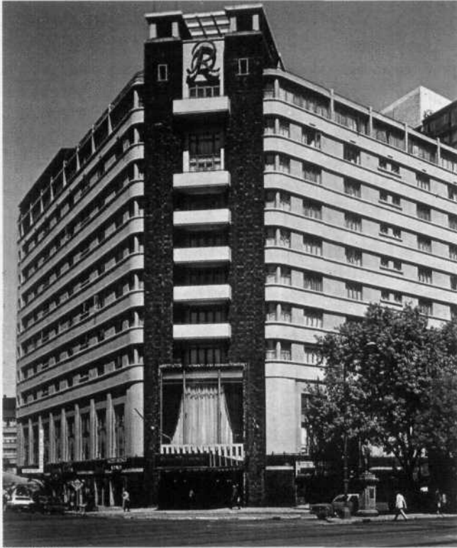
Hotel Reforma Arquitectos Carlos Obregón Santacilia y Mario Pani
