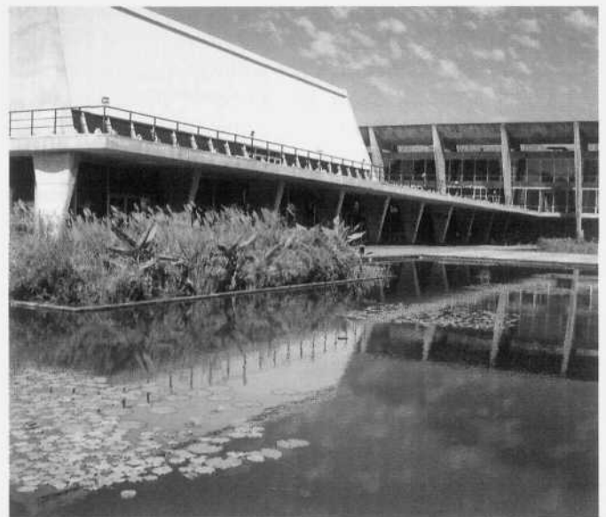
Sala de espetáculos del Museo de Arte Moderno de Rio de Janeiro , proyecto de Alfonso Reidy (1954), construido en 2007. Fotografía: Roberto Segre
