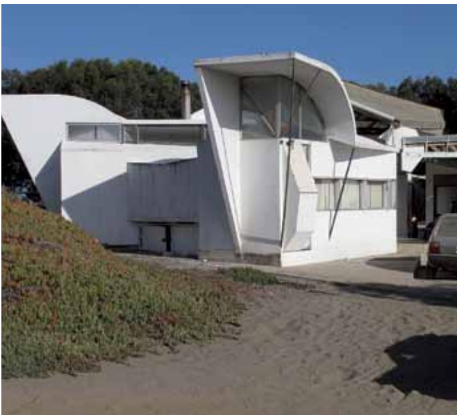
Hospedería Colgante o Taller de Obras
