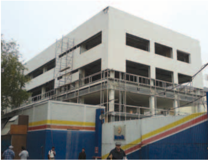
Fachada principal y lateral en obra
