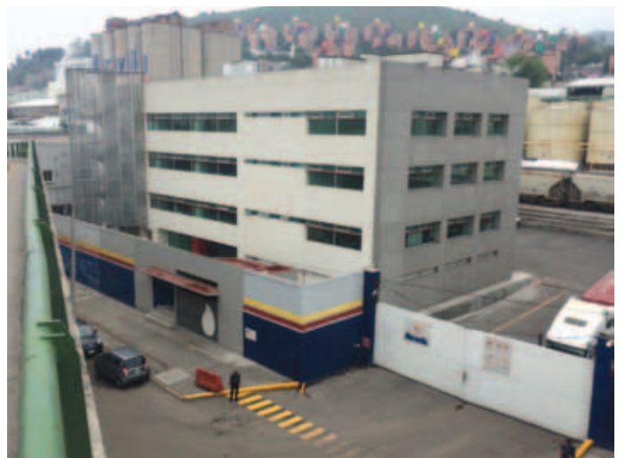
El edificio de oficinas terminado
