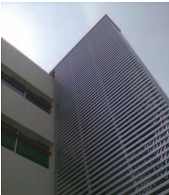
Patio interior de acceso, escalera de emergencia
