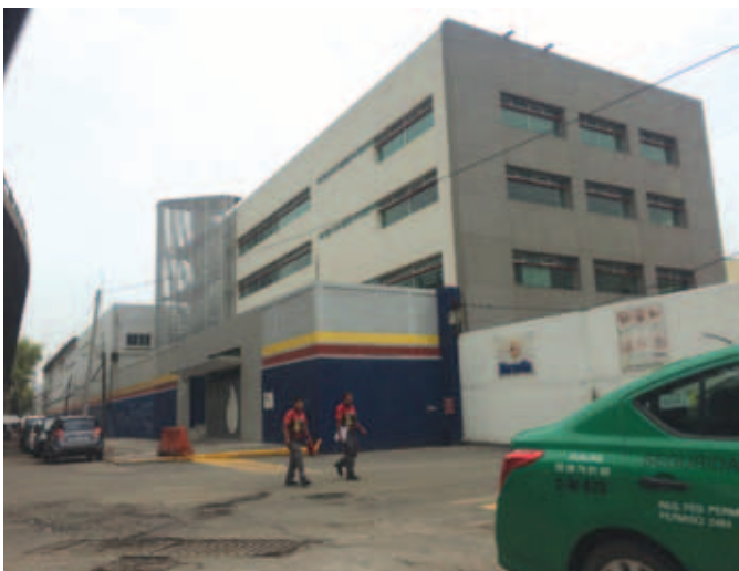
Fachada principal y lateral terminadas
