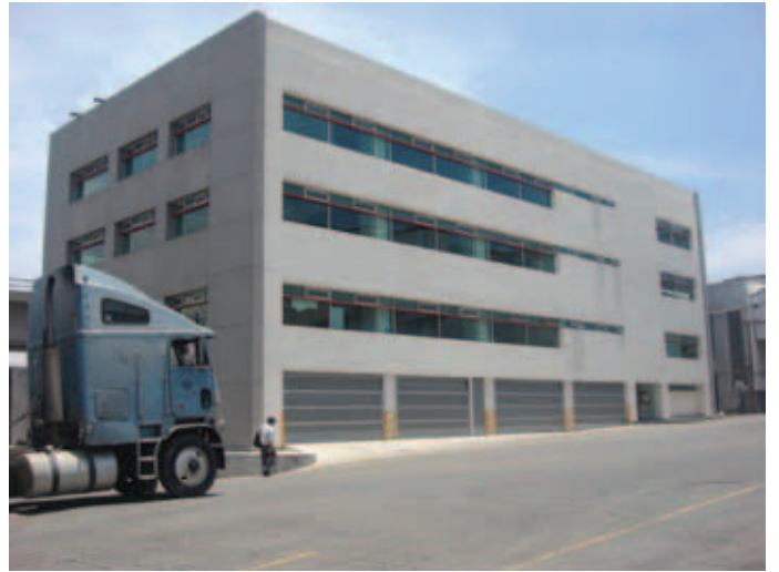
Fachada posterior y lateral terminadas
