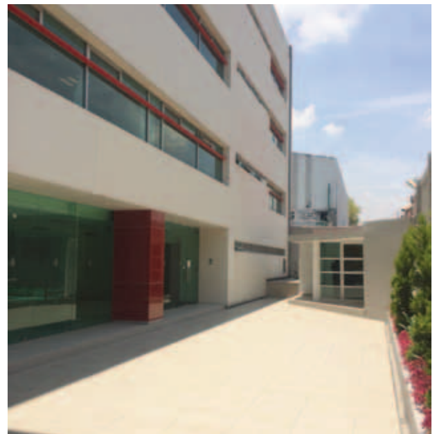
Patio interior de acceso, vista hacia la caseta de control
