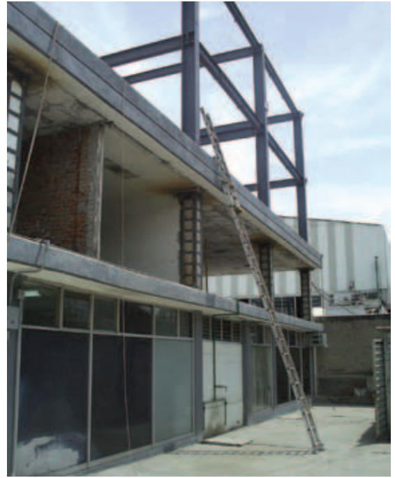
Fachada posterior, interior de la planta industrial
