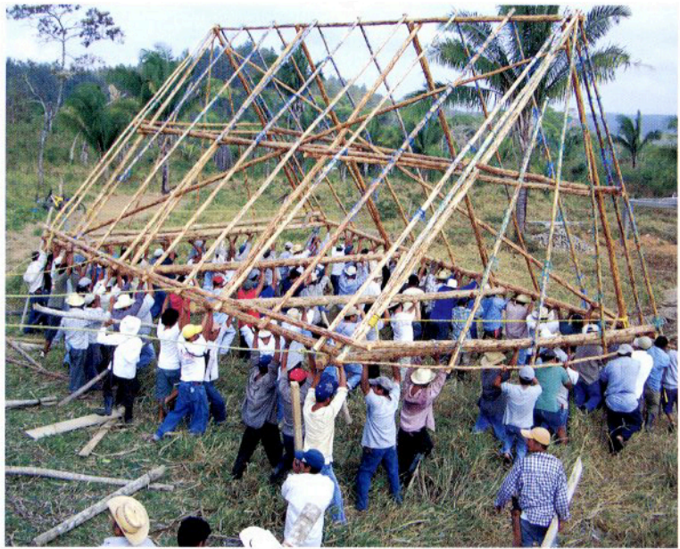
Techumbre de una de las aulas. Universidad Indígena Intercultural Ayuuk, Oaxaca, 2007-2008 Fotografía: Clara Azcué
