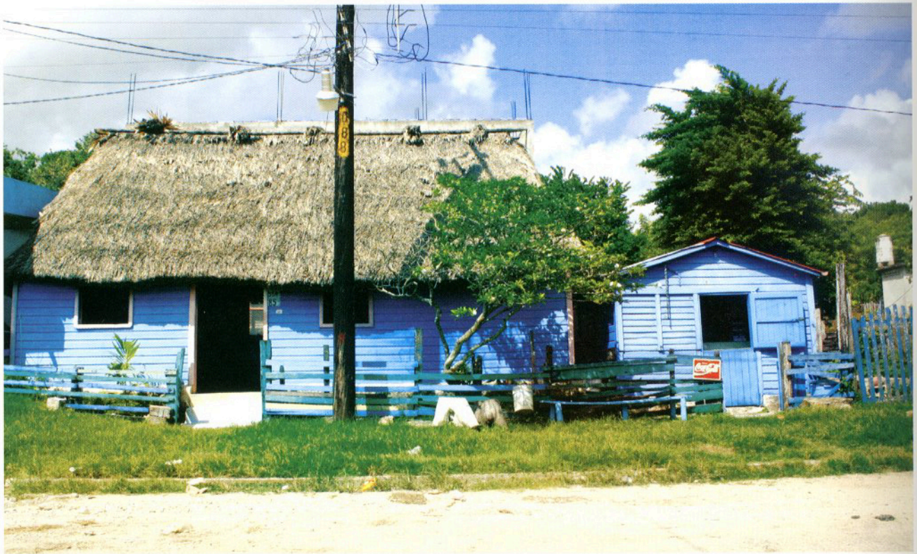
Casa en el poblado de Ramonal, Quintana Roo, esta población a orillas del río Hondo es producto de un antiguo embarcadero fluvial de maderas. Las viviendas presentan elementos provenientes de la cultura maya, como el techo de huano y las paredes de listones de madera del bungalow .
