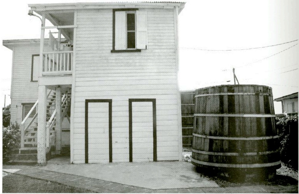
Fachada lateral de la Schofield House en Corozal, Belice. Los curvatos –enormes tinacos o barriles de retención de aguas pluviales para uso de sus habitantes– son sinónimo de sustentabilidad
