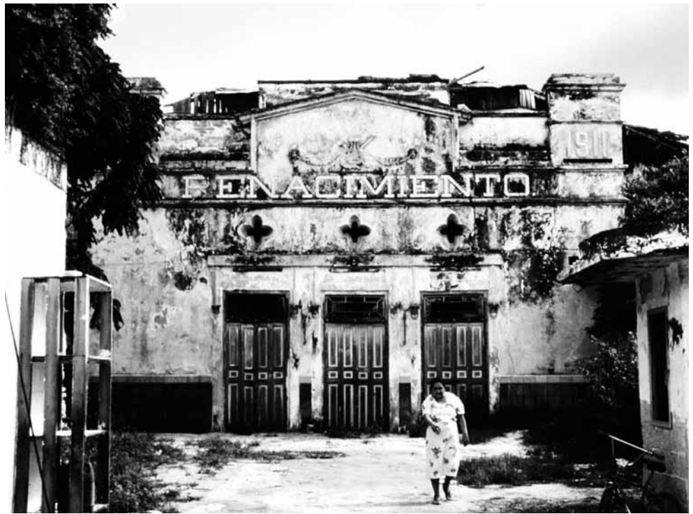
Estado del inmueble en 1993 Fotografía: Ivan San Martín
