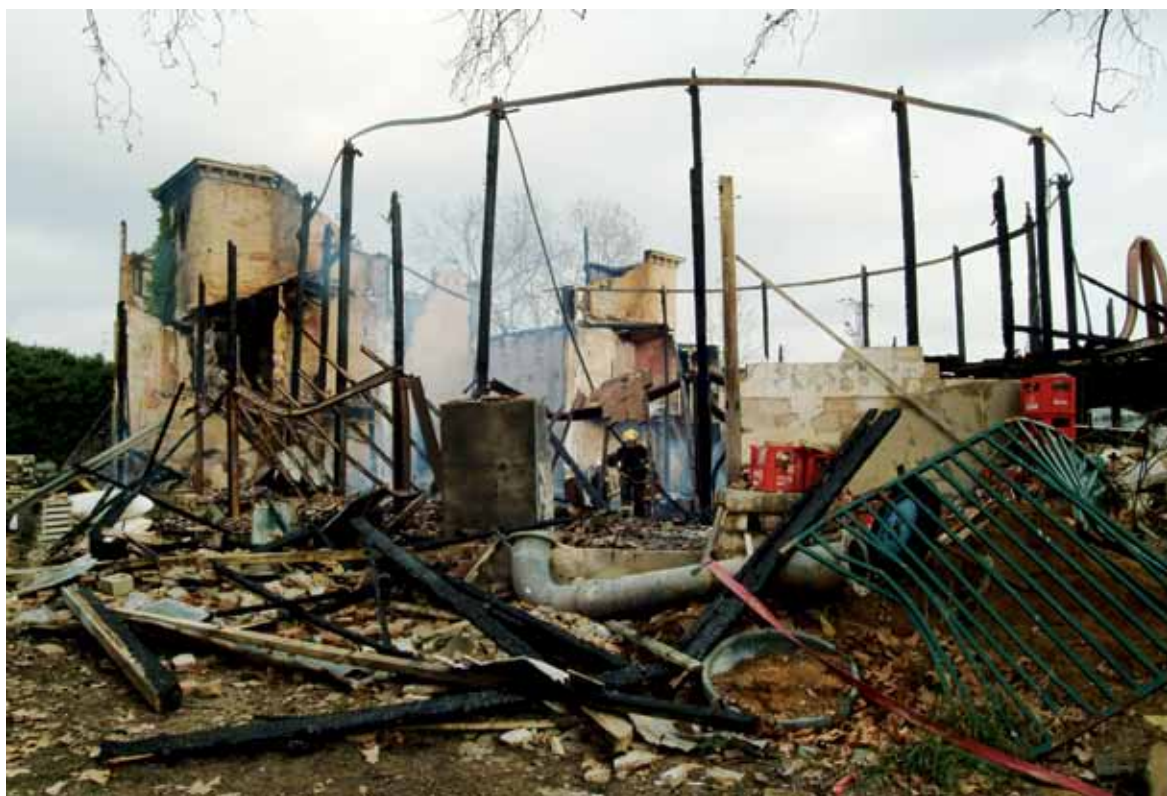
Teatro-Circo Apolo después del incendio, 2 de febrero de 2005 Fotografía: Félix Pascual, Diario de Vilanova
