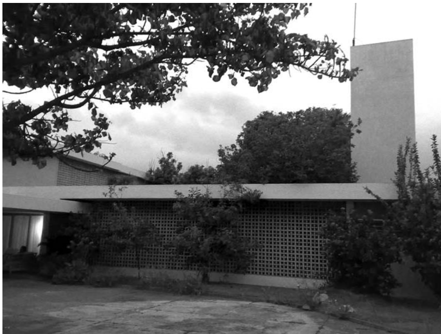
Casa-habitación de la Familia Brun, en la Calzada Galván 20, Colima, Colima. Los planos originales de la obra son de Bruno Cadore. La ejecución de la obra corrió a cargo del Ing. Arq. Antonio Ramos Salido Fotografía: María Mestre Martí
