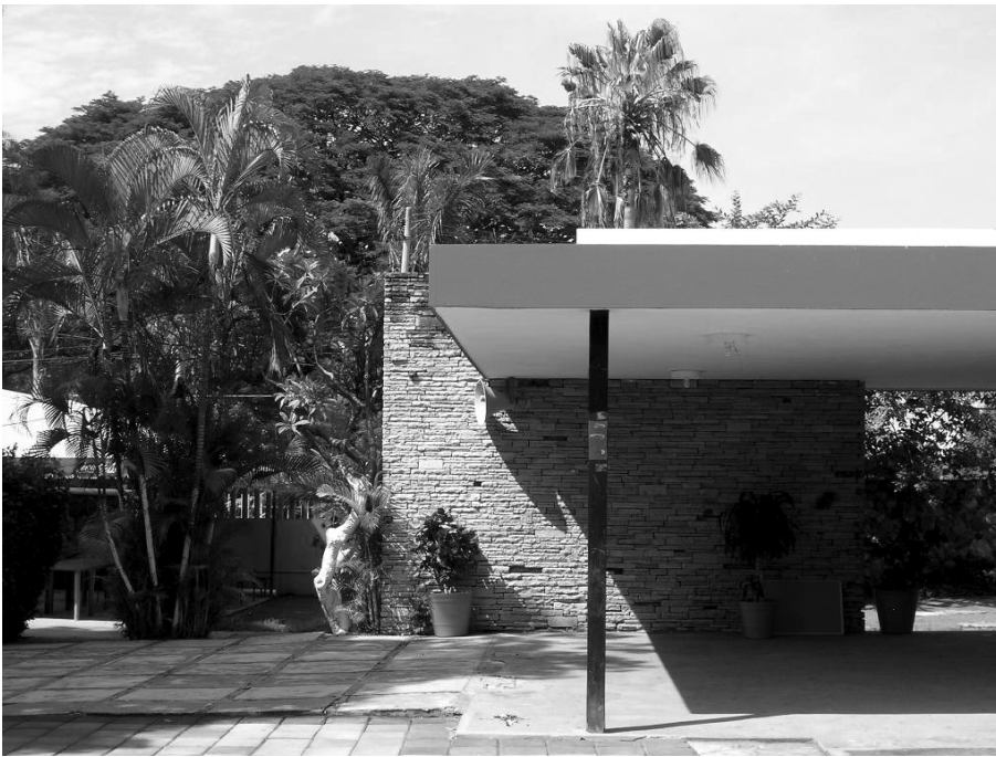
Casa-habitación en la C/ Morelos 565, actual Instituto Cambridge, Colima, Col. La losa flotante, así como el tratamiento del diminuto pilar metálico recuerdan las obras del arquitecto alemán Mies van der Rohe Fotografía: María Mestre Martí
