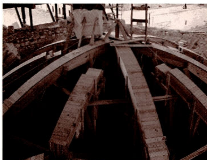
Cimbra para la bóveda de la capilla abierta.
