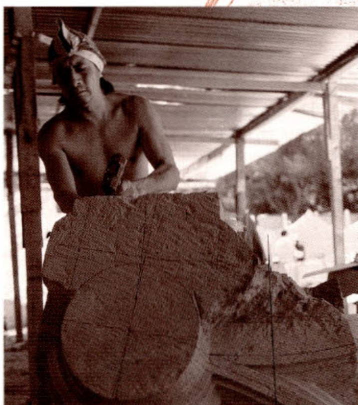
Labrado de una pieza para la bóveda de Teposcolula.
