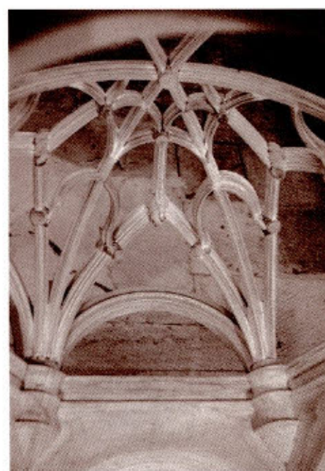
Nervaduras de la bóveda de la capilla abierta de Teposcolula. Maqueta en madera.
