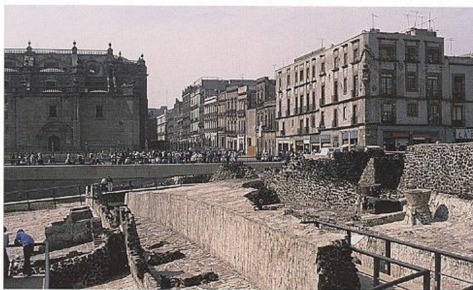
Estado original de la Casa de las Ajaracas (a la derecha de la imagen) con los restos del Templo Mayor en primer plano.
