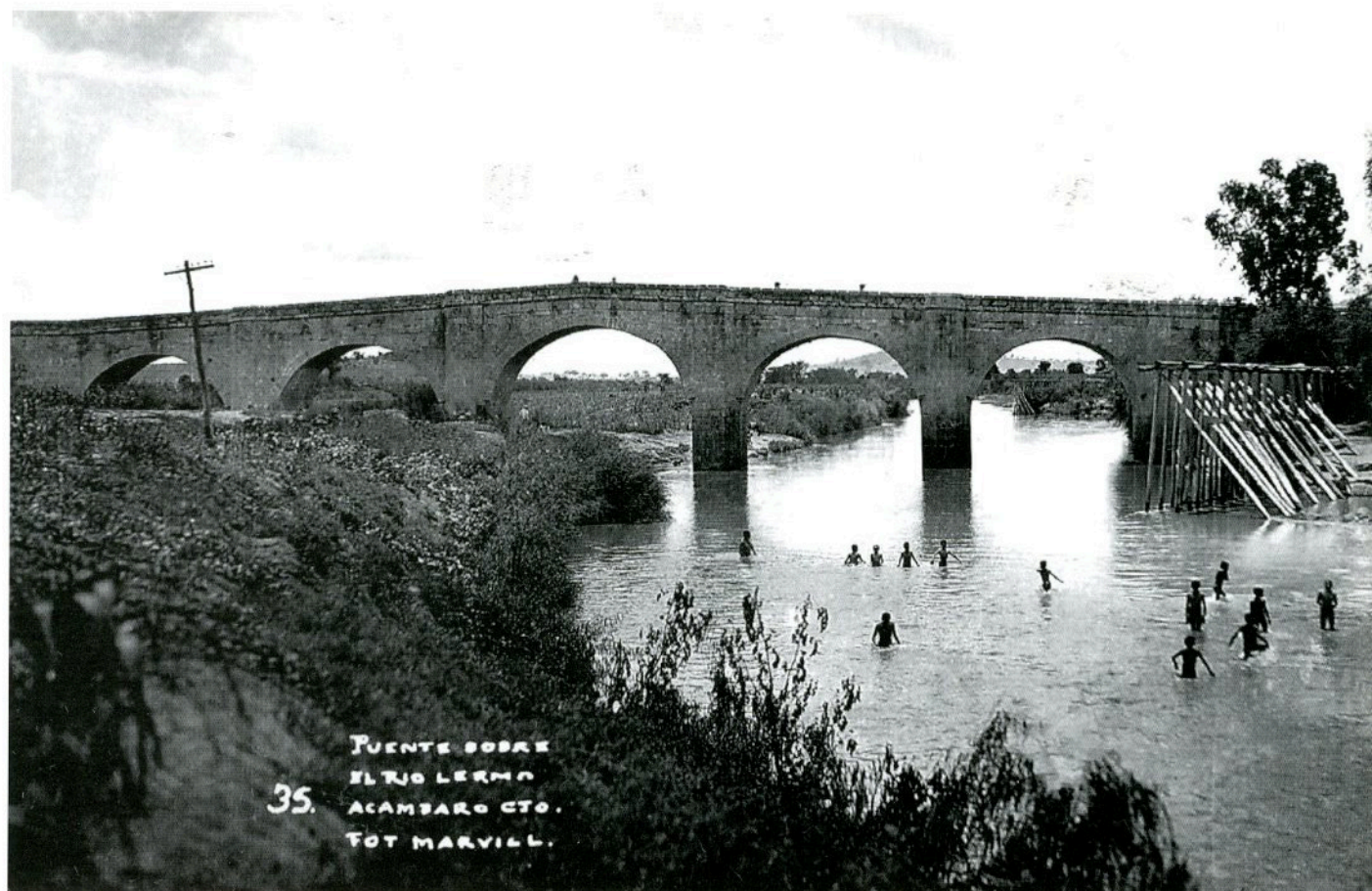
Puente sobre el río Lerma en Acámbaro, Guanajuato, siglo XVIII 35 CNMH-CONACULTA-INAH-MEX
