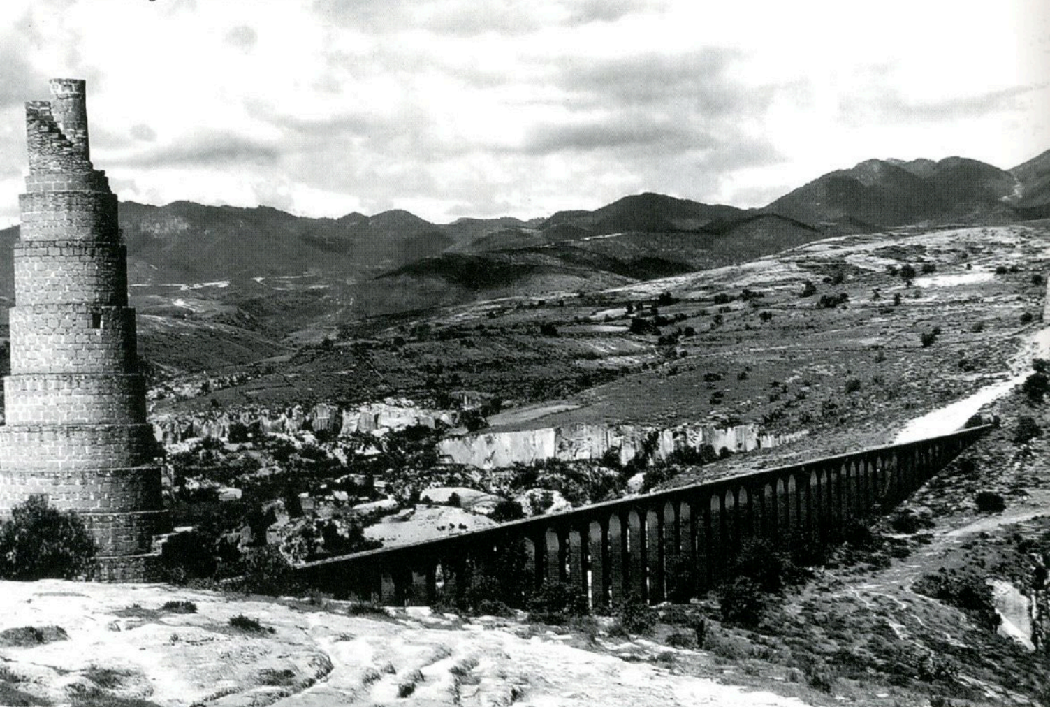
Acueducto de Los Remedios con las torres planeadas como respiraderos, Naucalpan, Estado de México, siglo XVII Fotografía: Hugo Brehme, (1920), 434-4 CNMH-CONACULTA-INAH-MEX
