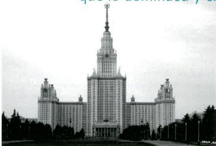
Lev Rudnev, torre central de la Universidad de Moscú, 1949-1953 http://www.muar.ru/ve/2003/moscow/
