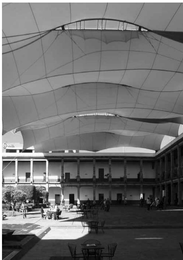
Ejes paralelos de la velaria enfatizados con el uso de cables en la membrana. DRV
