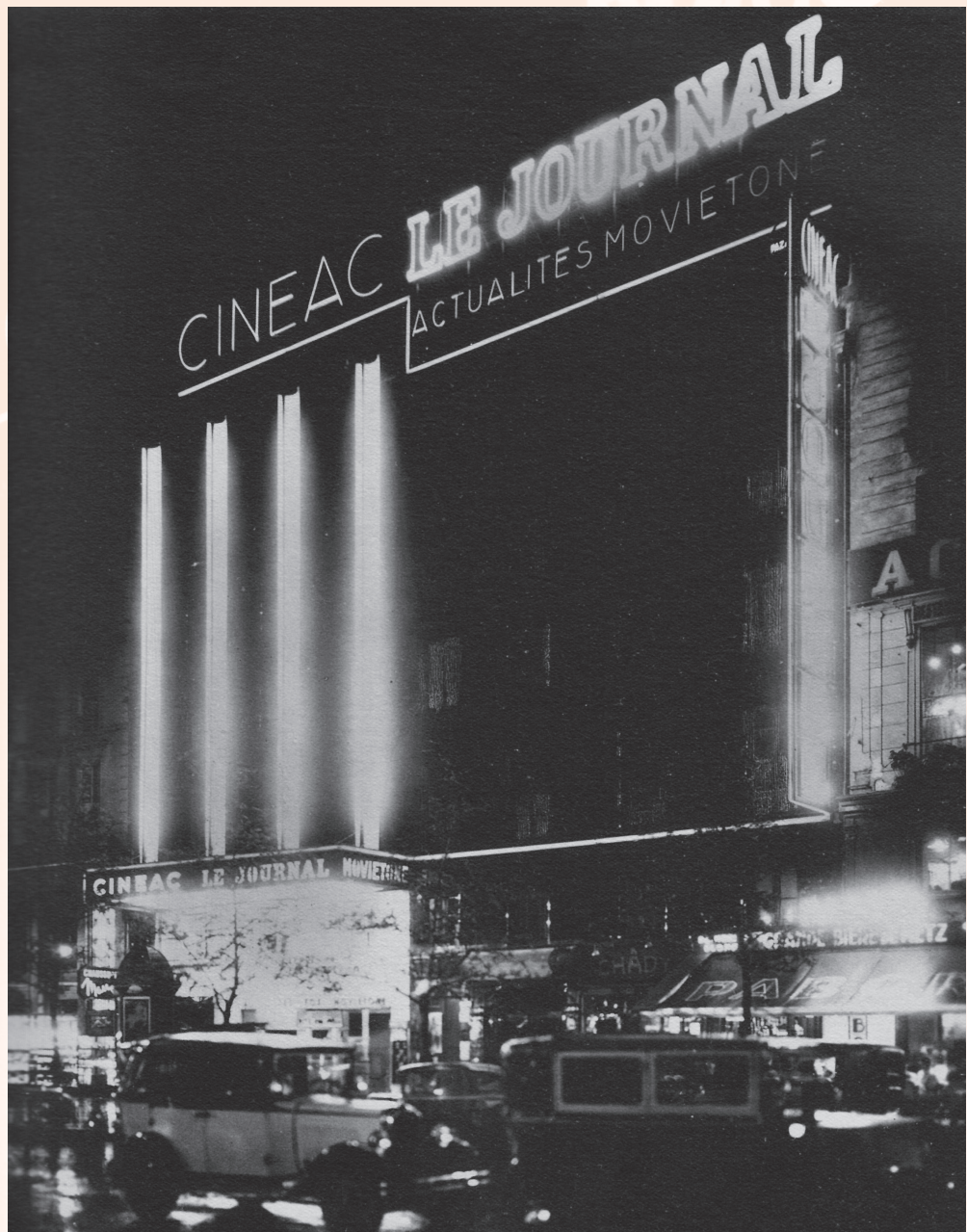
Fachada principal del cinéac Le Journal, 1931, París. Fuente: Vingt salles de cinema
