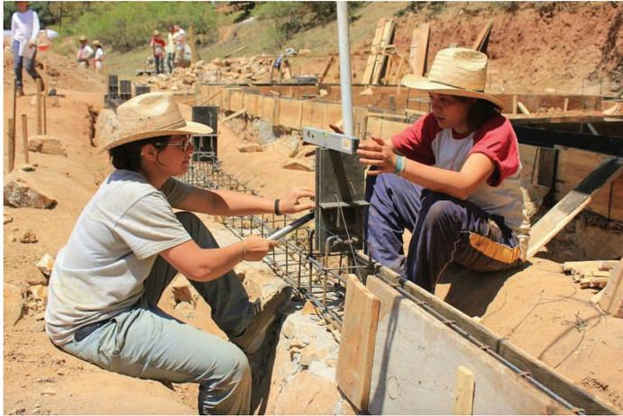
Colocación y nivelación de placas metálicas previas al colado de la cimentación que servirán para el apoyo de las columnas de madera por parte de dos alumnas del Politécnico di Torino, Italia. Centro Microrregional de Tecnología Sustentable, Pensamiento Liberal Mexicano, Oaxaca
