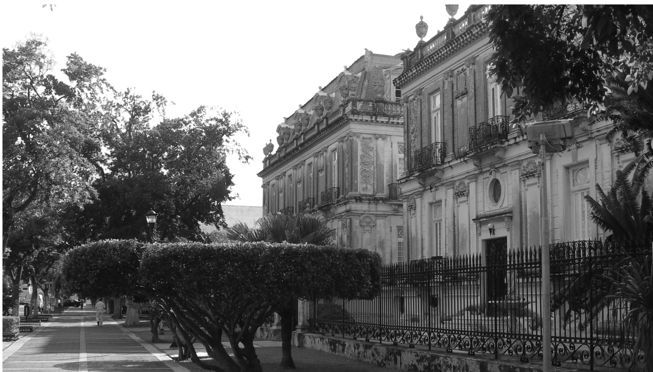
Casas gemelas. Fotografía: Ana de la Torre
