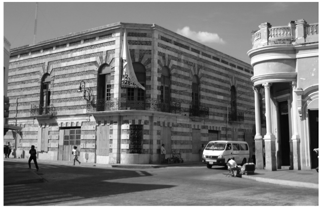
Imagen de una casa habitación ubicada en las calles 54 y 61. Una ejemplo de las grandes casas que se han reutilizado para actividades terciarias por sus dimensiones
