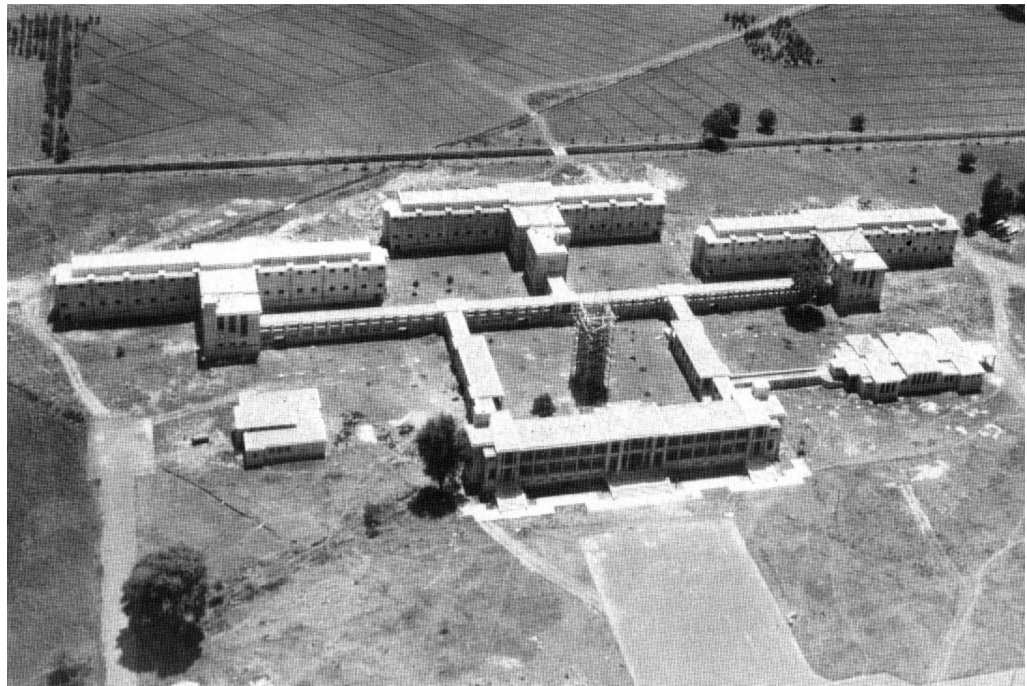
Fotografía aérea del edificio en construcción. José Villagrán García, México, Instituto Nacional de Bellas Artes, 1986
