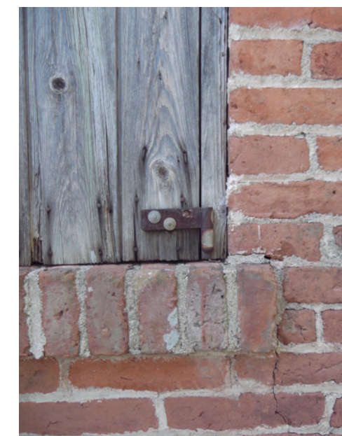
Detalles de la ventana y el muro en la casa rural de ladrillo en Castañer, Lares/Adjuntas. Para la década de 1930 el ladrillo había caído en desuso. El proyecto de casas experimentales de la PRRA buscó reactivar las industrias constructivas abandonadas. Fotografía: Dra. Luz Marie Rodríguez López, CIHTAD, 2019
