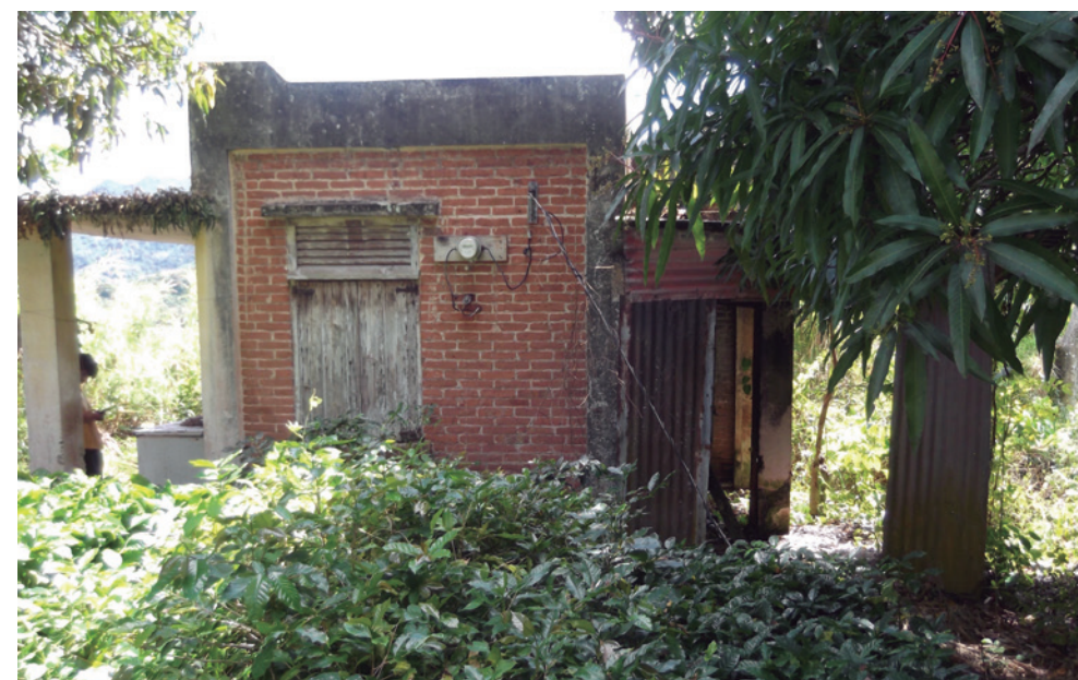
Modelo de casa rural de ladrillo con estructura de hormigón en Castañer, Lares/Adjuntas. Construcción por la Puerto Rico Reconstruction Administration (PRRA), c. 1936-1937. Fotografía: Dra. Luz Marie Rodríguez López, CIHTAD, 2019
