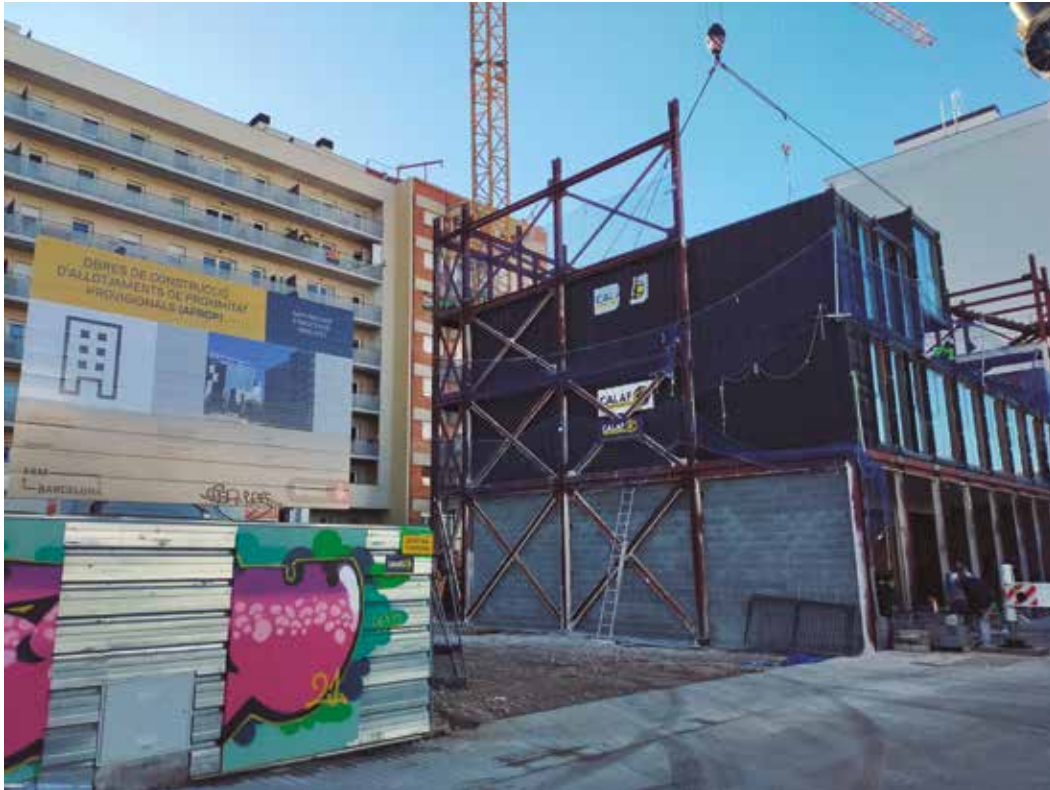
Imagen 6. Illa Glòries en construcció. Fotografia: Zaida Muxí Martínez.
