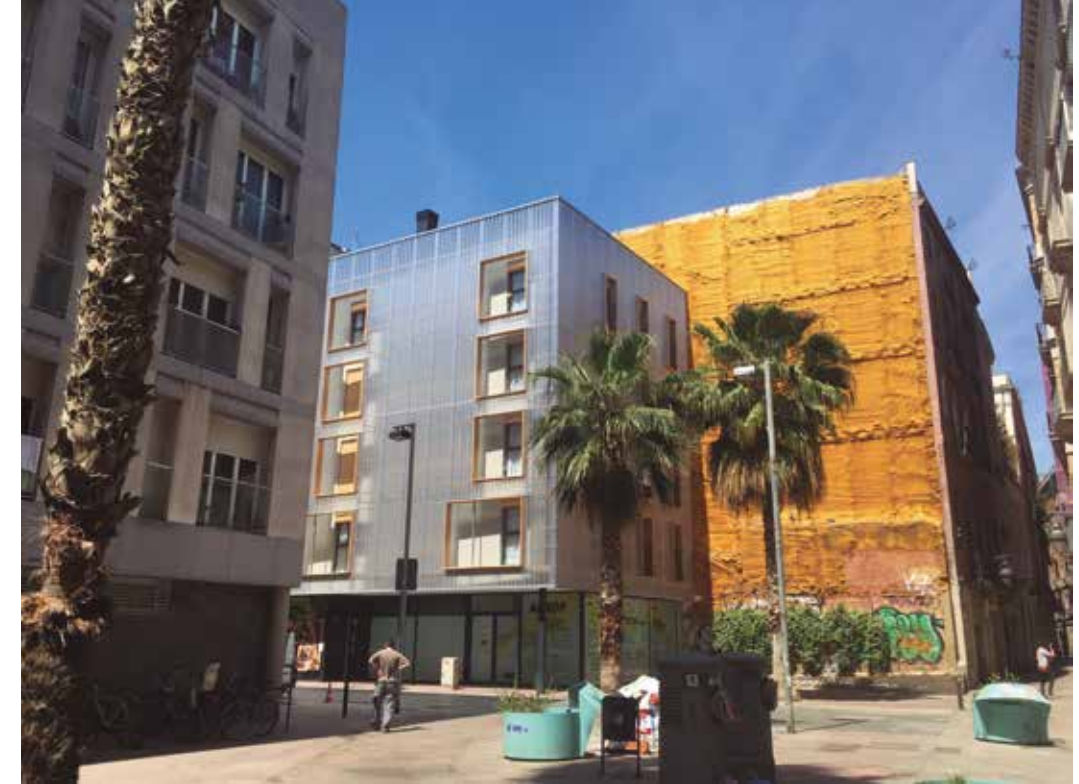
Imagen 5. Aprop Ciutat Vella, proyecto de vivienda social a partir de containers de Straddle3 + Eulia Arkitektura + Yaiza Terré. Fotografía: Zaida Muxí Martínez.
