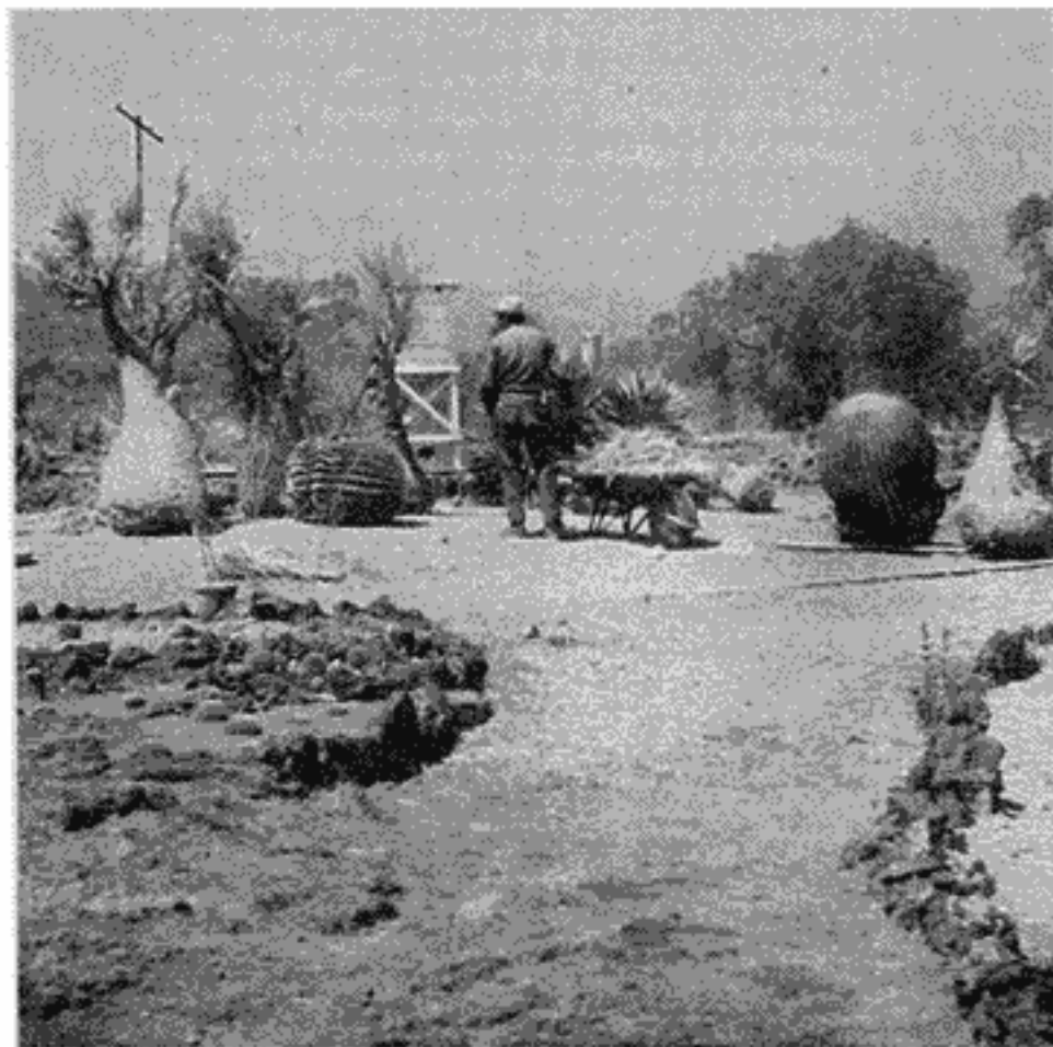
Inicio de los trabajos de formación del Jardín Botánico Exterior en la Ciudad Universitaria.
