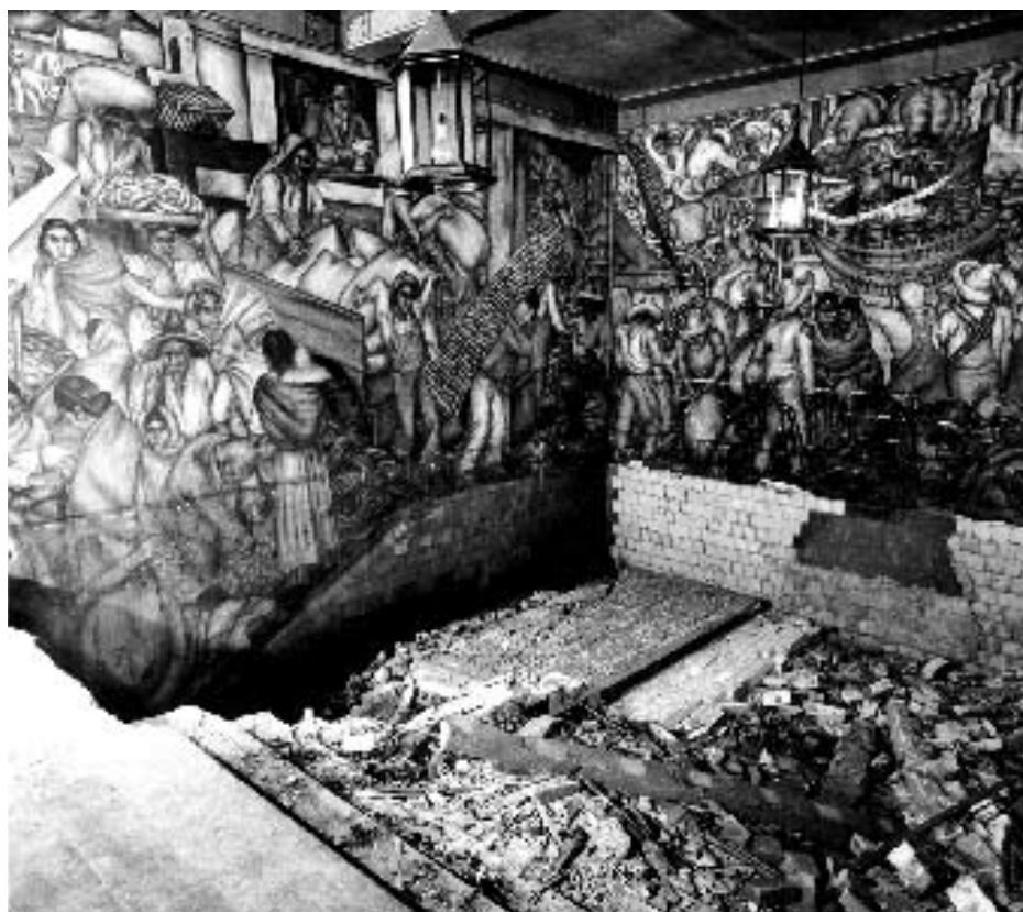
Marion Greenwood. Muros oriente y sur. Durante los trabajos de recuperación del cubo de la escalera. Se observan los daños considerables sobre el muro frontal con la pérdida de las piezas en el guardapolvo.
