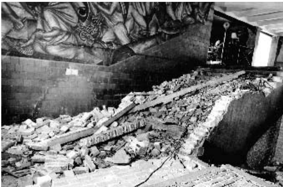
Marion Greenwood. Después de la demolición de los muretes, en la parte baja, se observan los agregados cancelando el paso hacia el primer piso.
